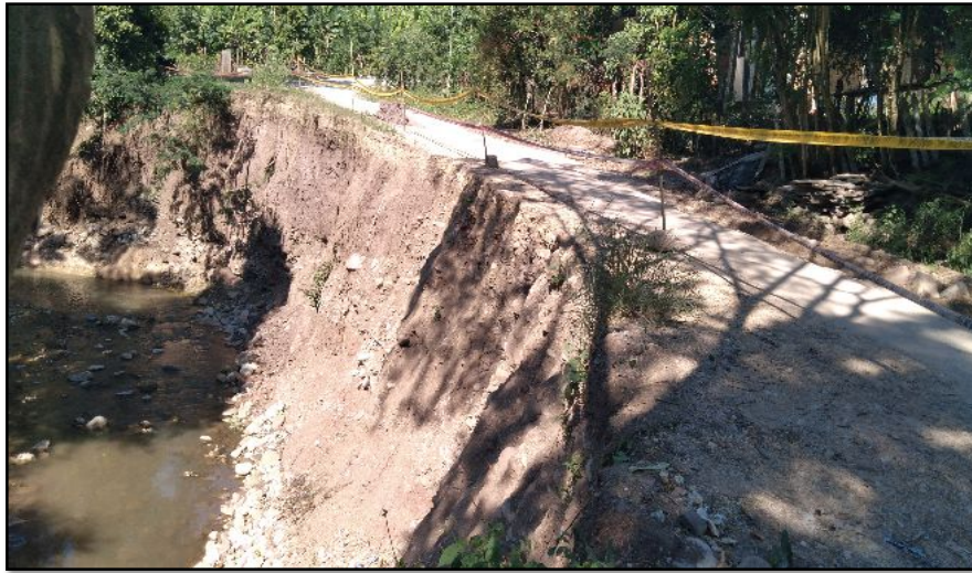
FOTOGRAFIA N°01: EROSION DE LA RIBERA DE LA QUEBRADA QUE AFECTA A CARRETERA
